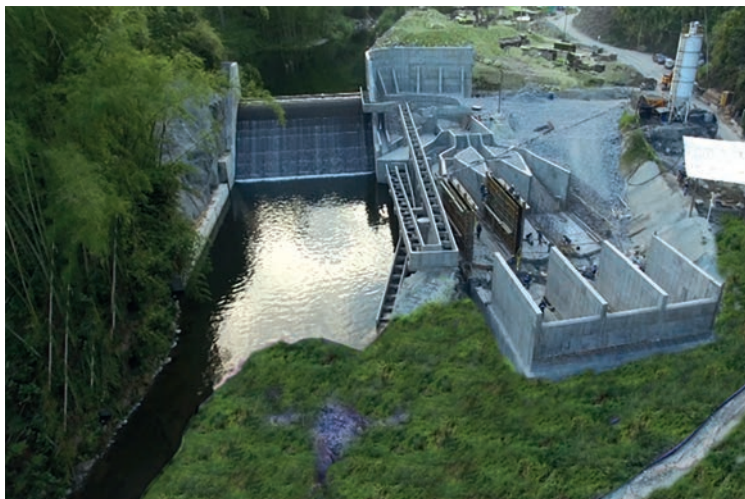
Figura 21. Obras de captación del proyecto hidroeléctrico El Edén
