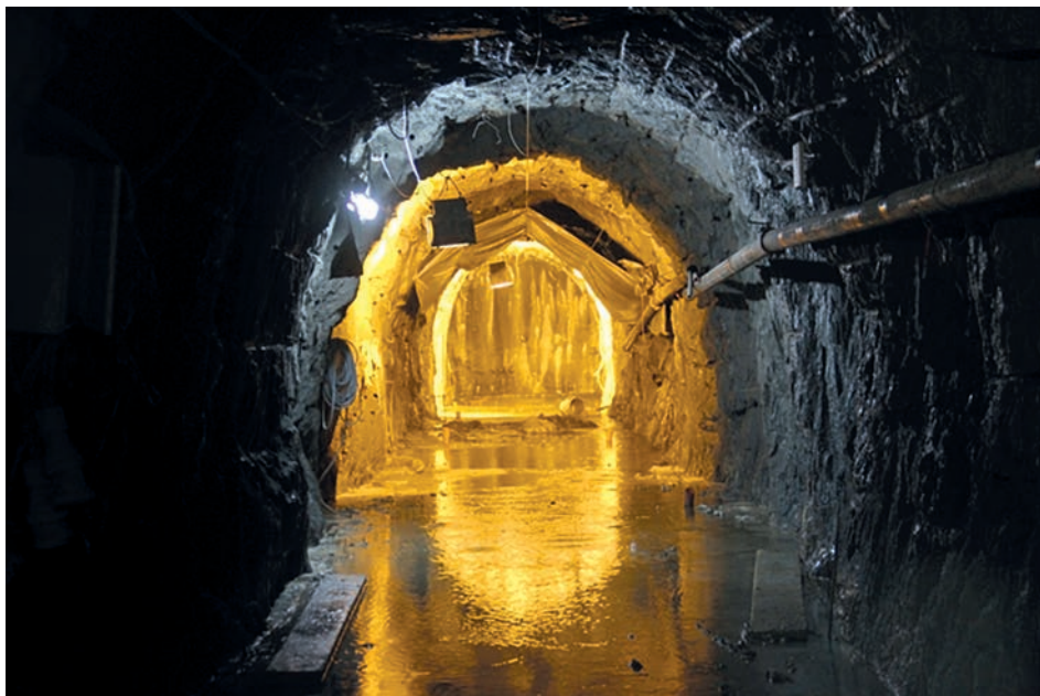
Figura 23. Túnel de conducción de aguas del proyecto hidroeléctrico El Edén
